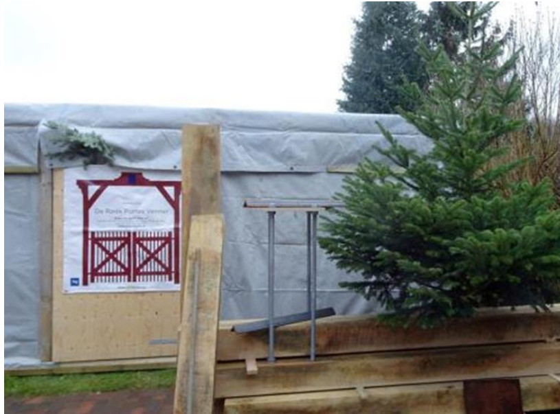
Arbejdsteltet er blevet etableret/bygget
